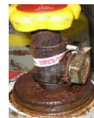
Foto 2 Korrodiertes Ventil
