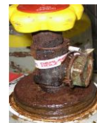
Foto 2 Korrodiertes Ventil
